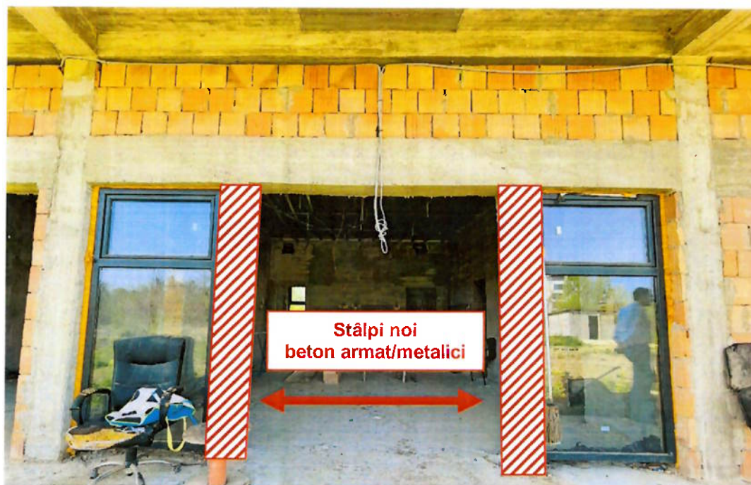
Detaliu de principiu susținere buiandrugii beton armat
