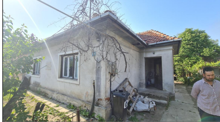
FIG.3 VEDERE CURTE ACCES LOCUINTA EXISTENTA 101 mp
