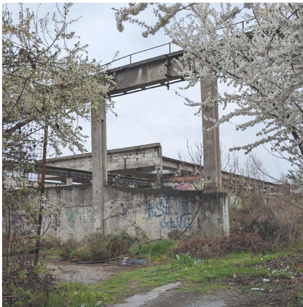
Terenuri neutilizate Vedere dinspre parcare Iulius Mall, cu acces de pe Bulevardul Antenei
