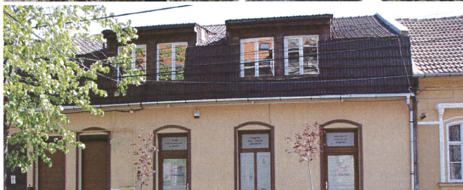
Exemple de modificare volumetrică prin mansardare, pe întreaga lungime a acoperișului sau doar pe o anumită porțiune, lucrări prin care s-a modificat aspectul inițial al imobilelor istorice: Str. Alexandru Odobescu nr.21, Str. Treboianu Laurean nr.6, Str. Ady Endre nr.16
