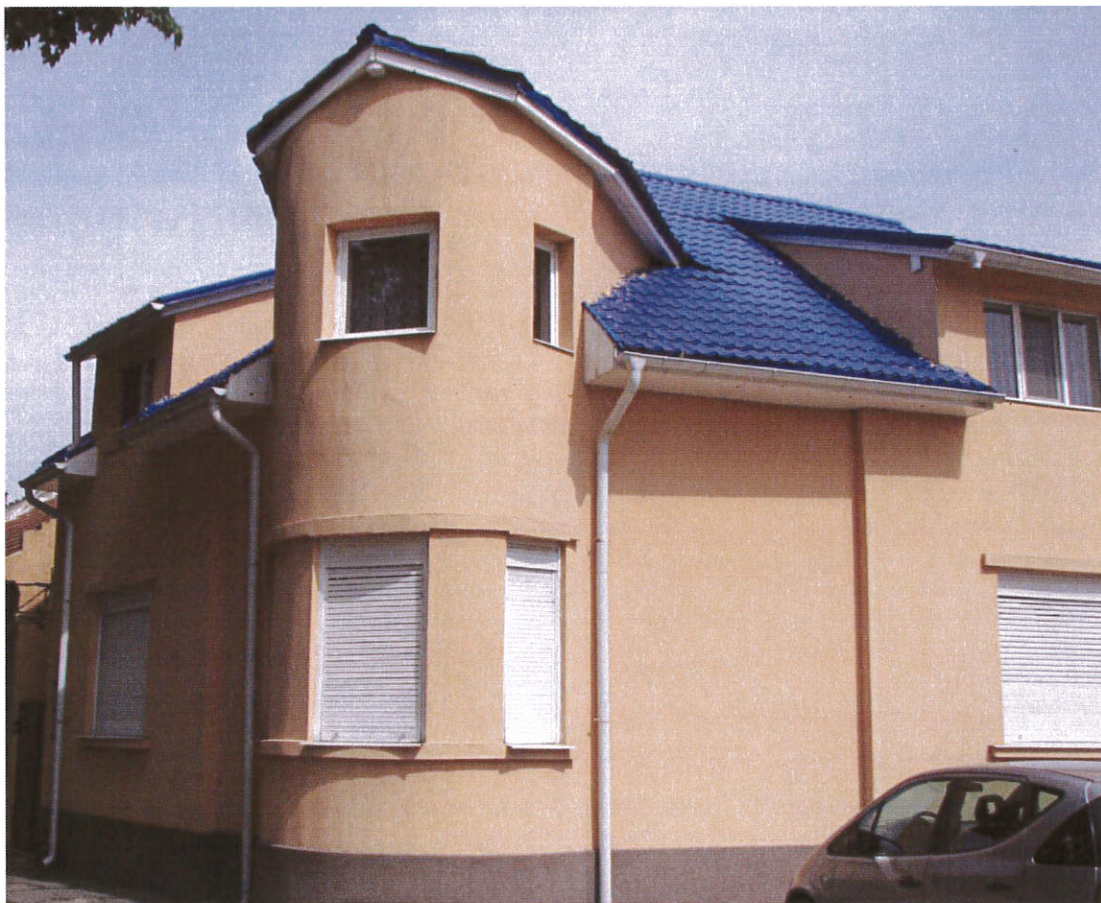
Memorandumului nr.63A – volumetrie contrastantă cu aspectul general tradițional al străzii și folosirea de materiale necorespunzătoare la realizarea acoperișului (țiglă din tablă de culoare albastră)
