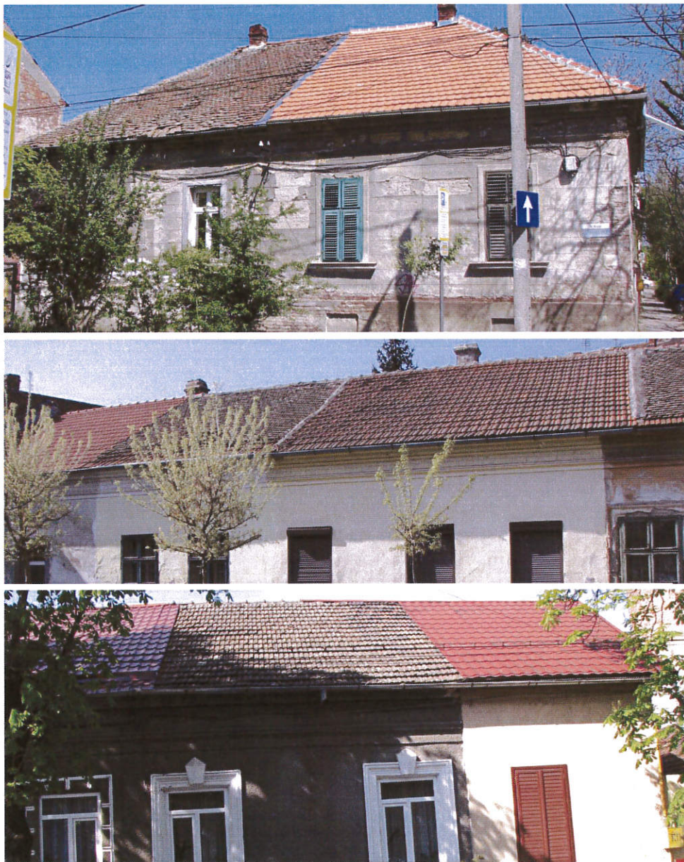
Lucrări doar pe anumite porțiuni de acoperiș, în unele cazuri și cu materiale necorespunzătoare zonelor istorice protejate. Exemple, de sus în jos: Str.Treboianu Laurean nr.8, Str.Ion Ghica nr.24, Str.Anton Seiler nr.11
