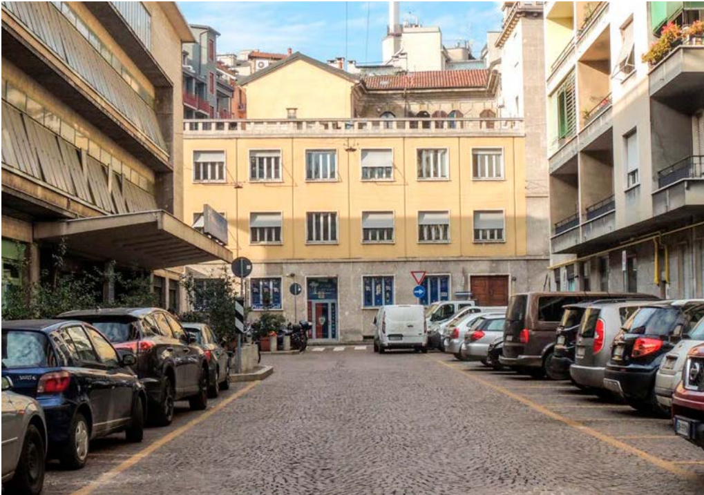
carosabil din cuburi de porr
