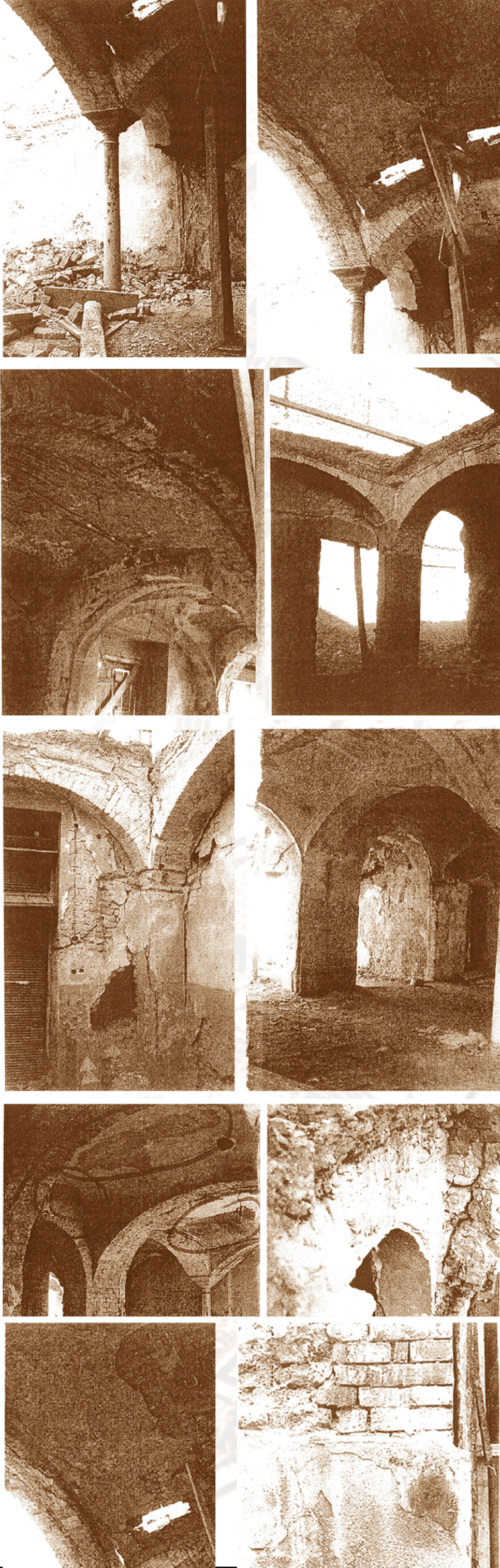
POZE interior CLADIRE- INAINTEA DEMOLARII
