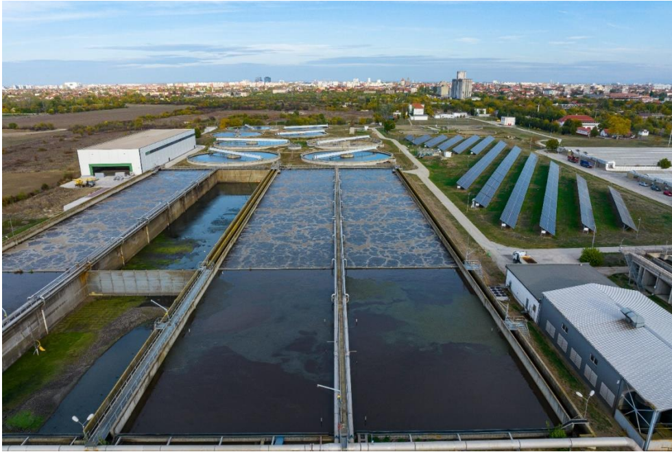
Stația de epurare a apei uzate Timișoara, Aquatim SA
